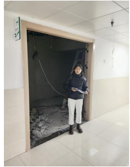
工程师现场踏勘照片
