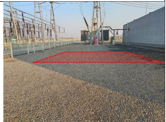
拟建#2 主变建设场地
