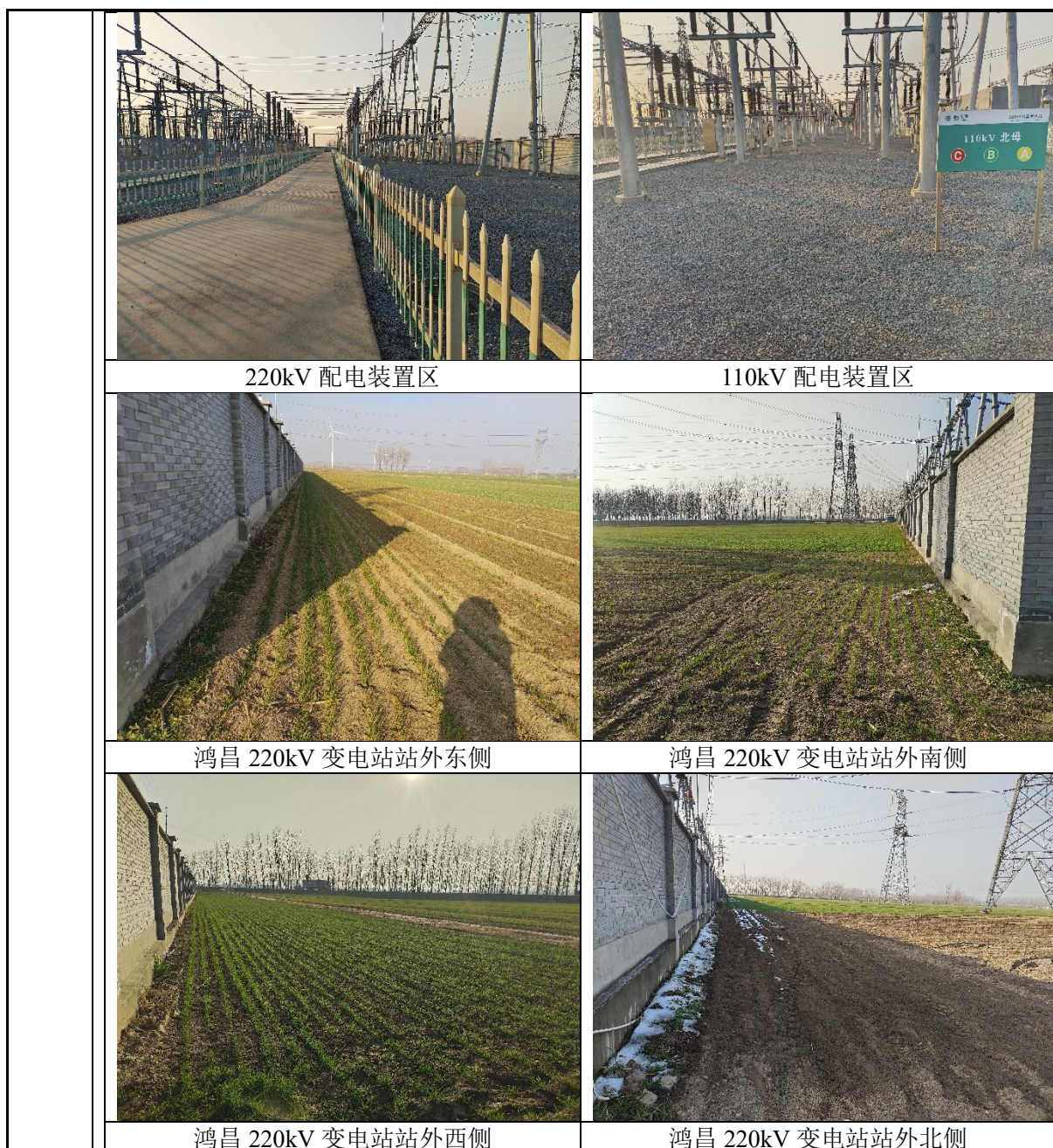
图 4 工程站内设施和站外区域环境现状
