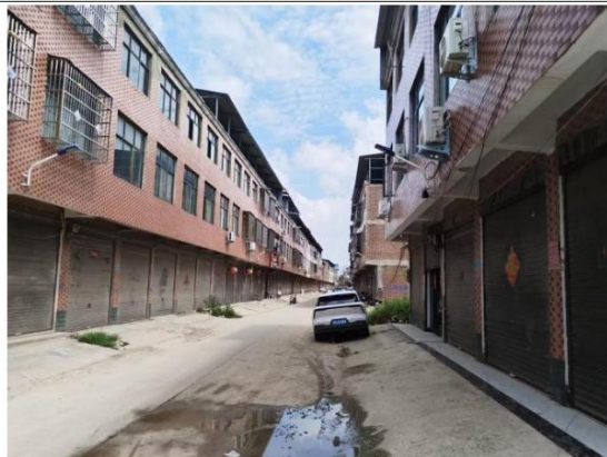
项目西侧临街商铺
