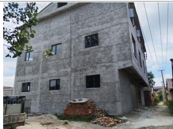
项目北侧卫生院家属院
