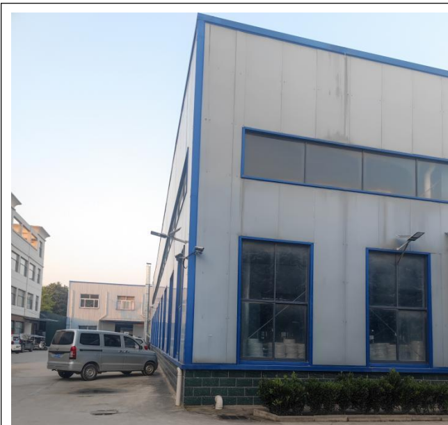
项目北侧（周口市华讯实业有限公司厂房）
