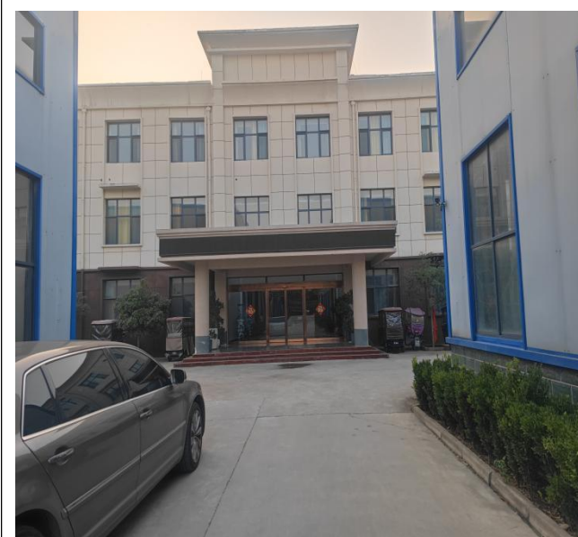
项目西侧（周口市华讯实业有限公司办公楼）
